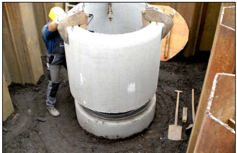
Bild5: Neuerstellung der Schachtbauwerke
