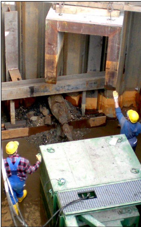
Bild4: Die Bersthülse erreicht die Maschinengrube
